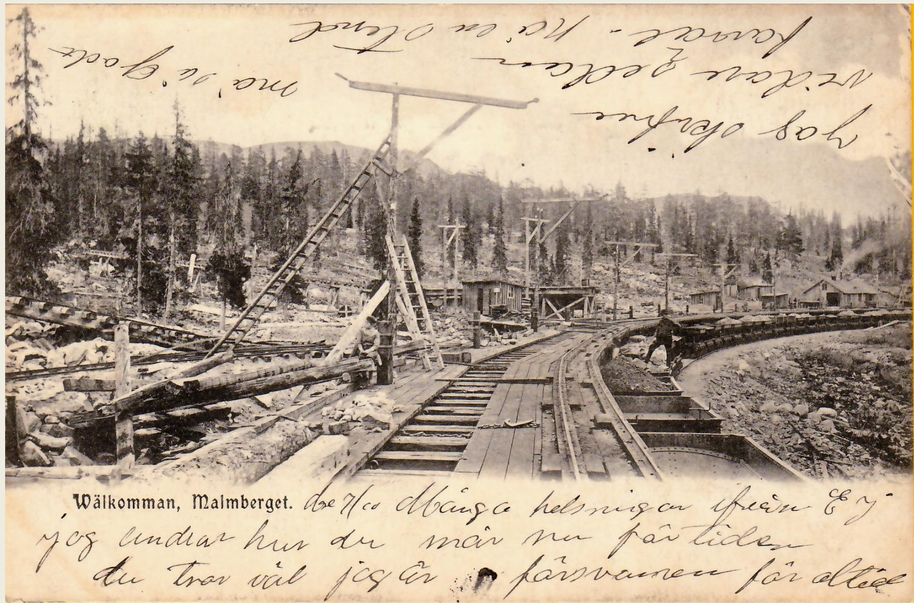
Malmberget, infart till gruvan, se träställningarna inför elektrifieringen
