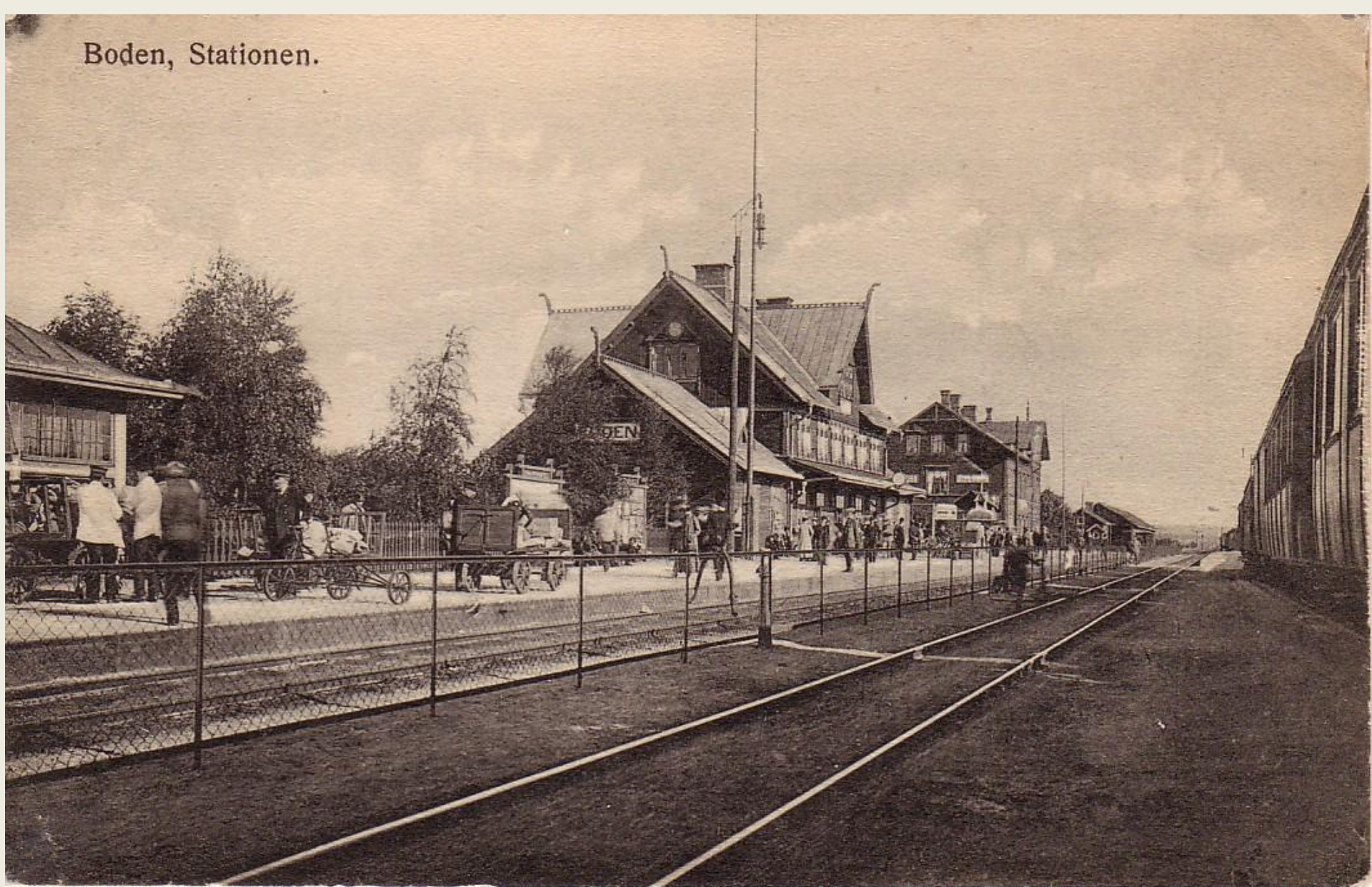
Bodens stationshus byggt 1894
