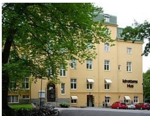
Huvudentrén i augusti 2010 med skylten Idrottens Hus
