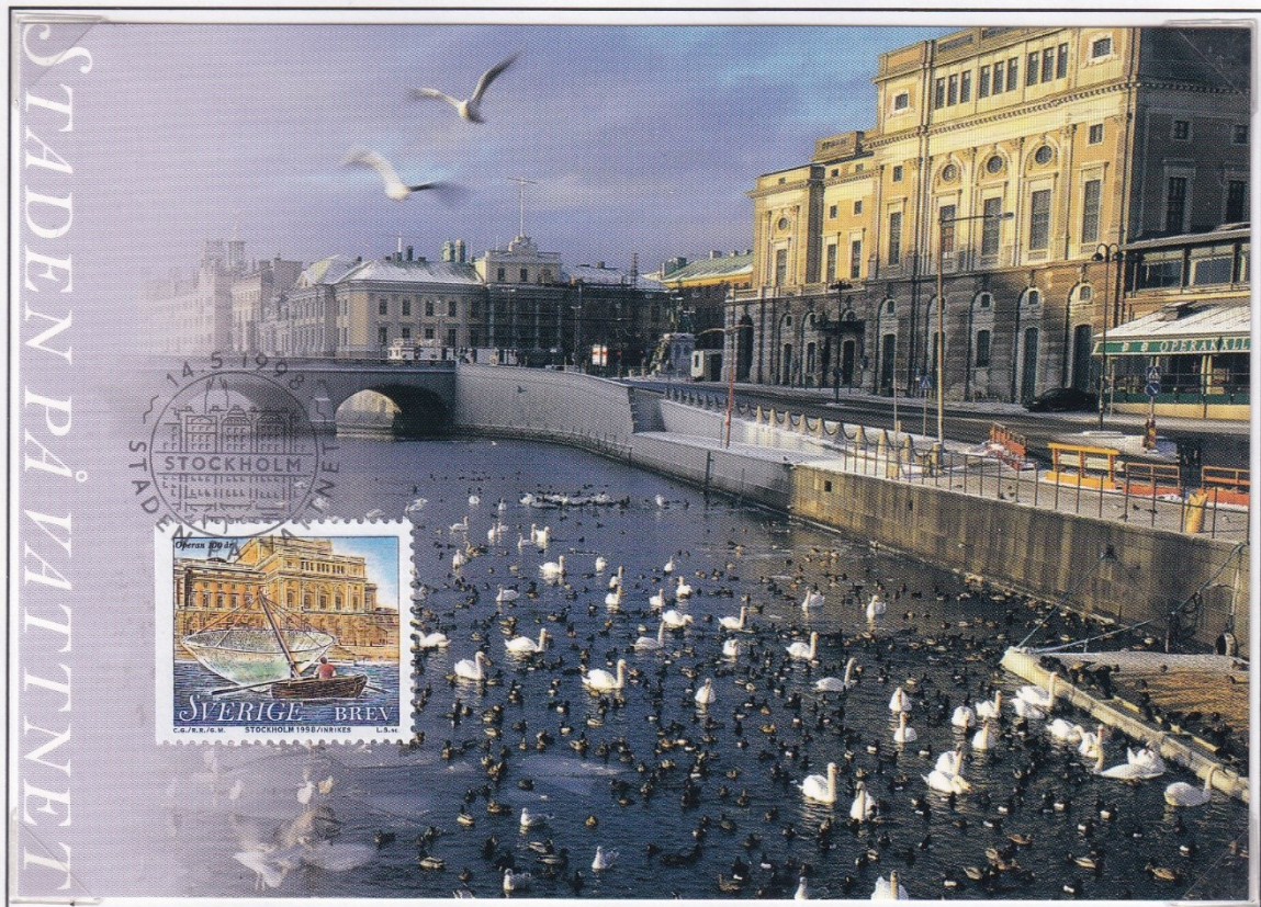
Den nuvarande byggnaden, vid Gustav Adolfs torg, invigdes 1898
